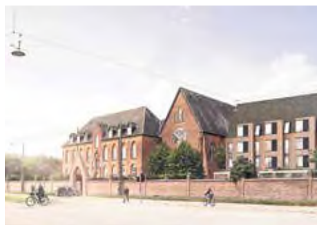
Sådan vil klosterbygningerne på Strandvejen komme til at se ud, når de første beboere kan flytte ind i slutningen af 2019. Simulationsbillede fra Rubow Arkitekter.
