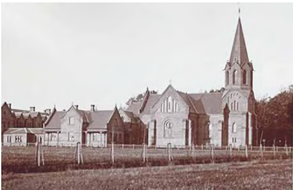
Sankt Andreas Kirke i Ordrup ca. 1875. Til venstre for kirken ses præstegården, og i baggrunden til venstre ses den gamle skolebygning (kollegieflojen). Mellem denne og præstegården ses en forbindelsesgang, der i mellemkrigstiden blev udbygget til den nuværende menighedssal. Bemærk, hvor landligt det hele dengang var: Kirken og kollegiet ligger mellem åbne marker. Foto: www.danskebilleder.dk.
