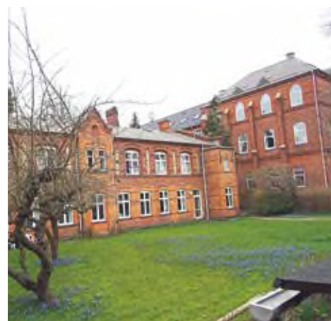
Den gamle skolebygning (kollegieflojen) set fra haven bag Sankt Andreas Kirke. I baggrunden ses tilbygningen fra 1913 med huskappellets spidsbuede vinduer på anden sal. Foto: Sebastian Olden-Jørgensen.
