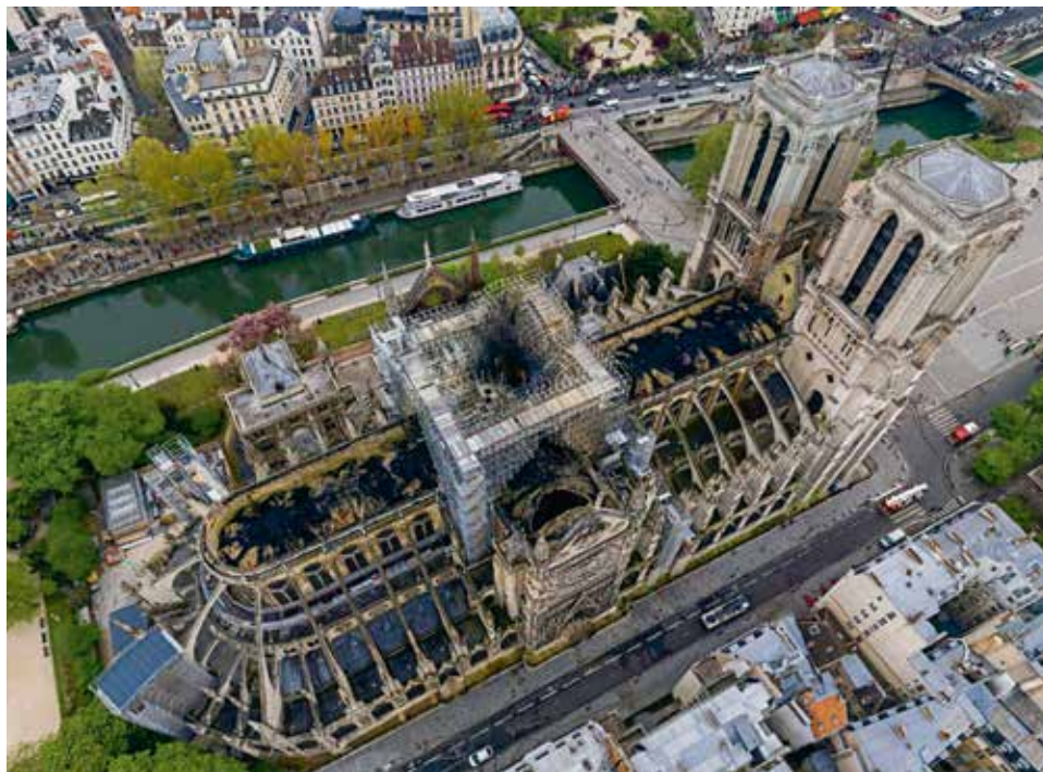
Et luftfoto viser de omfattende skader på domkirken Notre-Dames tagkonstruktion som følge af branden den 15. april.
