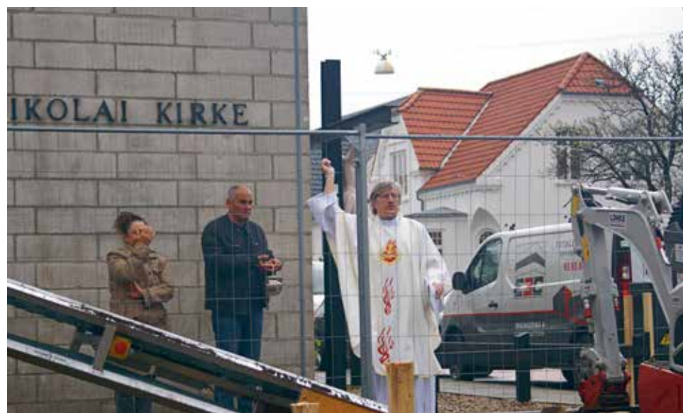
Sognepræst Benny Blumensaat velsigner byggepladsen, da arbejdet er gået i gang.
