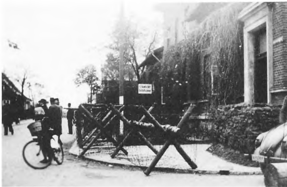
Fig. 5. I 1919 blev huset taget i anvendelse som dommerbolig og sidebolig som embedsbolig for Hjørrings politimester. I en periode under den 2. verdenskrig tog de tyske besættelsestropper kontorerne i brug og forskarvandede bygningen med pigtråd og skytegrave.
