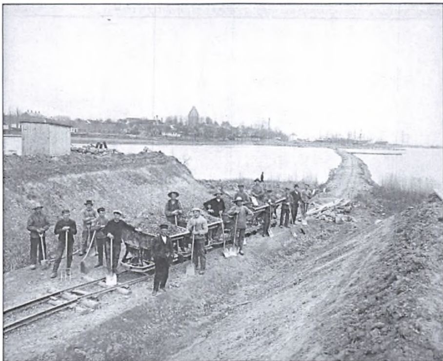
Ved anlæggelsen af banen blev der bygget en dæmning over Noret og en bro over Fribrødreåens udløb. Noret er siden blevet fyldt op, og der er nu anlagt fodboldbaner.
