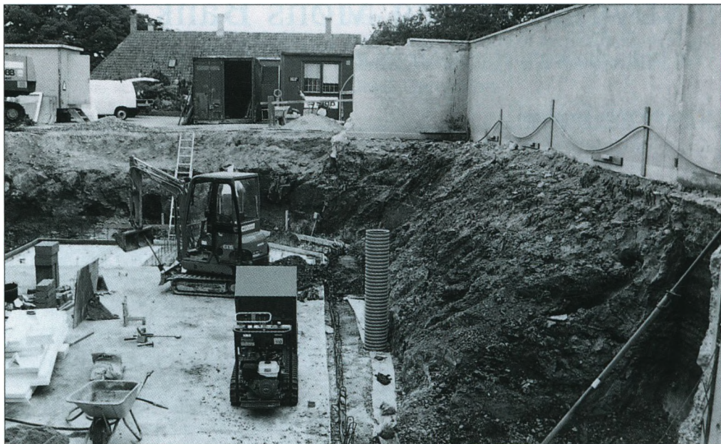
Byggepladsen bag Møns Bank. Fundamenterne til nybyggeriet ligger ved bunden af 2-3 m byaflejringer fra middelalderen.
