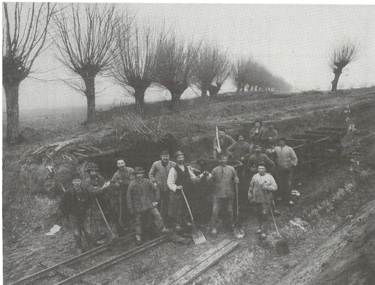
Jordarbejdet er i gang.
