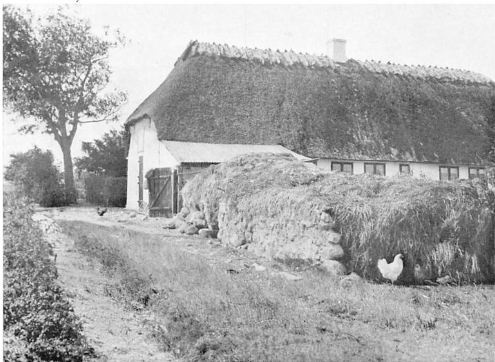
HJELMSHOVED. Ved øens nordre hus. Udhusene er bygget af sten og tang. (186)
