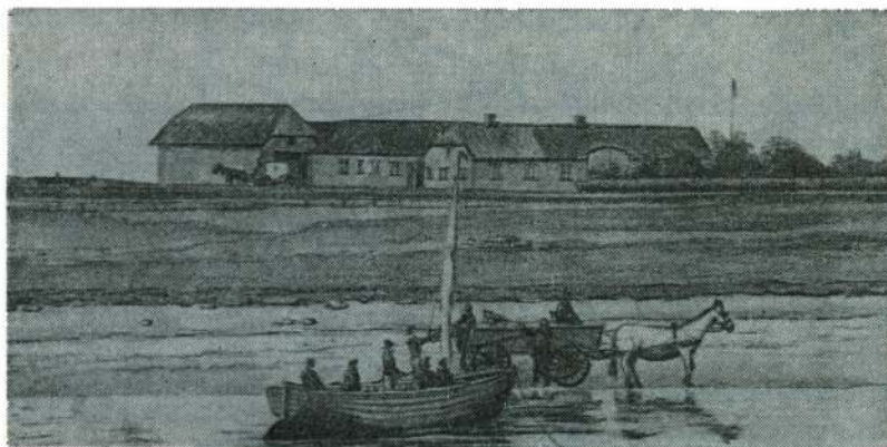
På Fanø Museum i Nordby findes ovenstående idealiserede tegning, der viser folk fra Fanø under landsætning ved Strandby Kro. Postvognen står klar til at befordre de rejsende videre.
