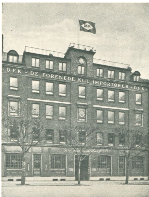
De forenede Kulimportørers Bygning, Holmens Kanal Nr. 5.
