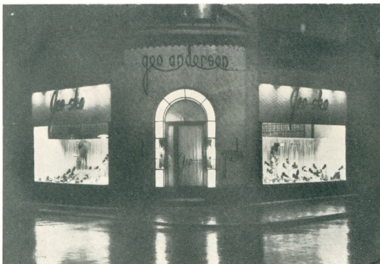
Geo Sko, Forretningsejendommen Vimmelskafte Nr. 35.
