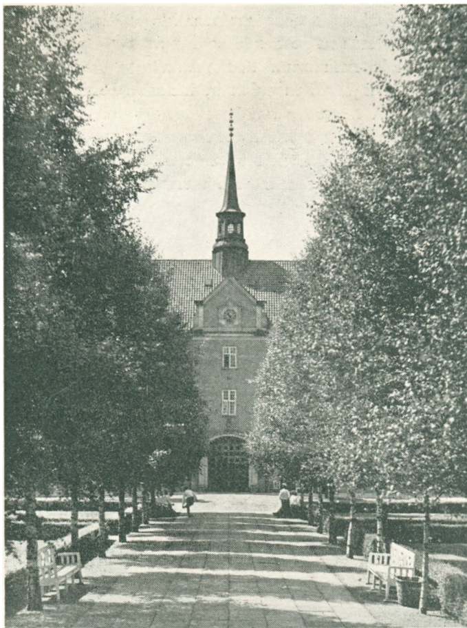
Administrationsbygningen, Københavns Militærhospital set fra Grønnegaarden.
