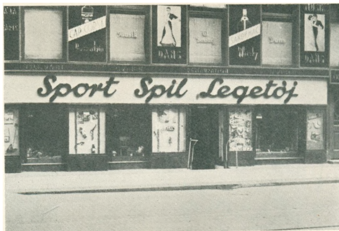
St. Kongensgade 62 efter Ombygningen.
