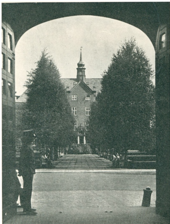
Sygeplejerskeholigen, Københavns Militærhospital, set fra Administrationsbygningen.
