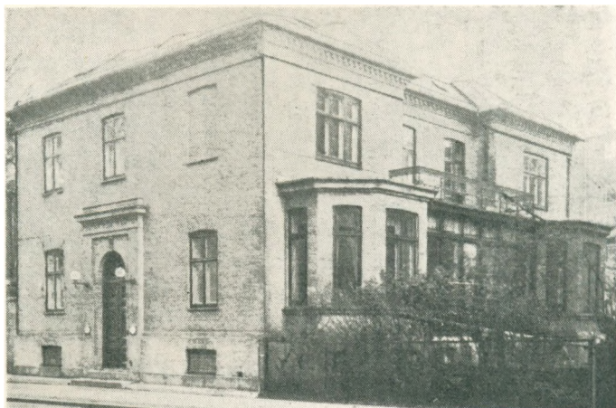
Sygehjemmets Bygning, Kochsvej Nr. 5.
