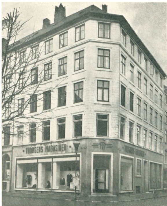
- Thomsens Magasiner's Ejendom Nikolaj Plads Nr. 13 efter Ombygningen.
