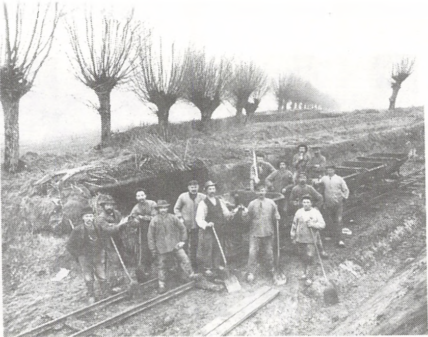
Anlæg af jernbanen mellem Horbelev og Særslev. ca. 1910
