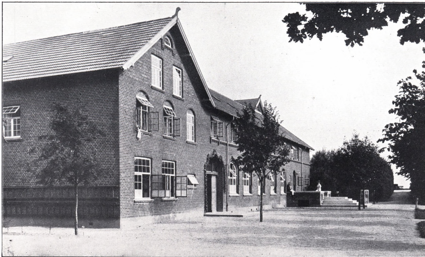
Elevbygningen mod Vest.
