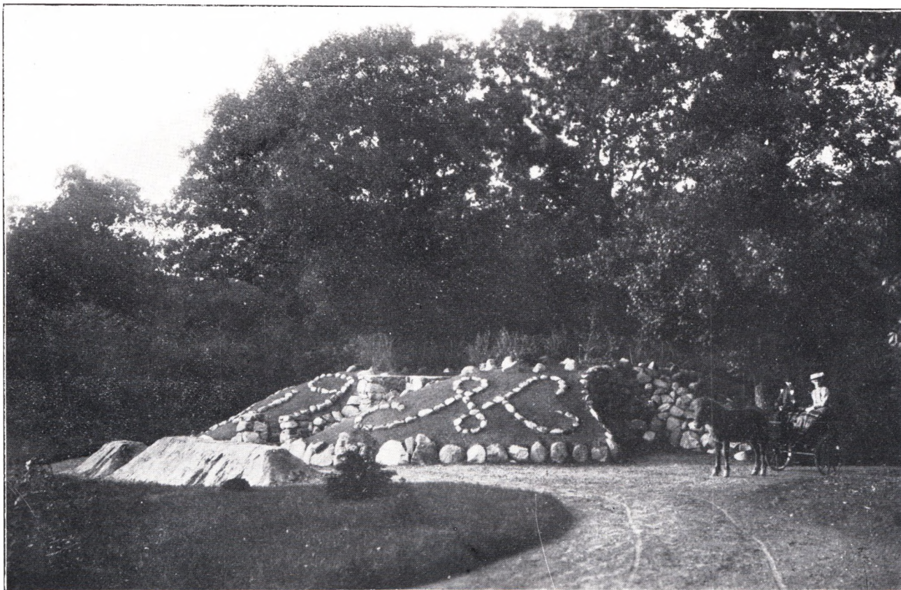
Højen under Opførelse, set fra Øst.
