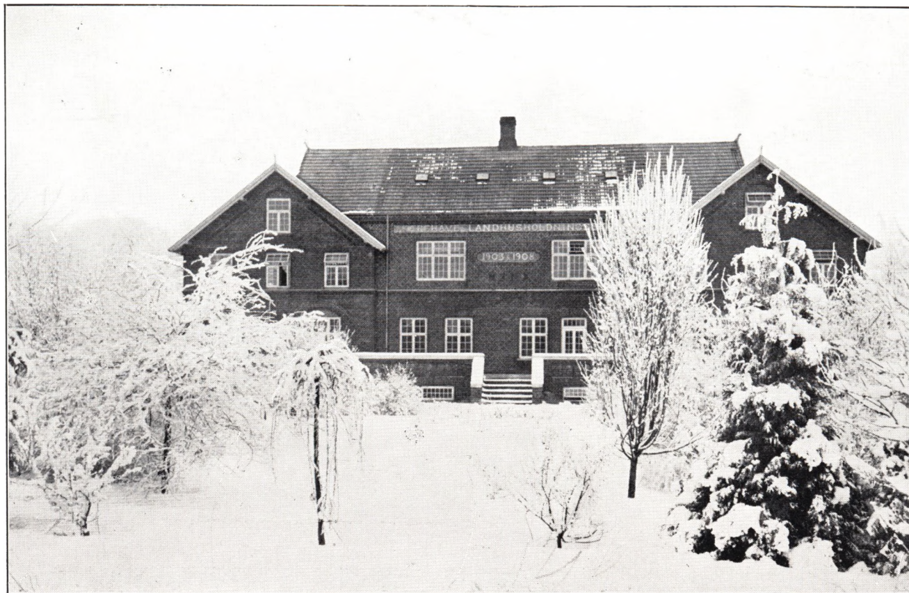
Haven og Elevbygningen mod Syd i Sne.
