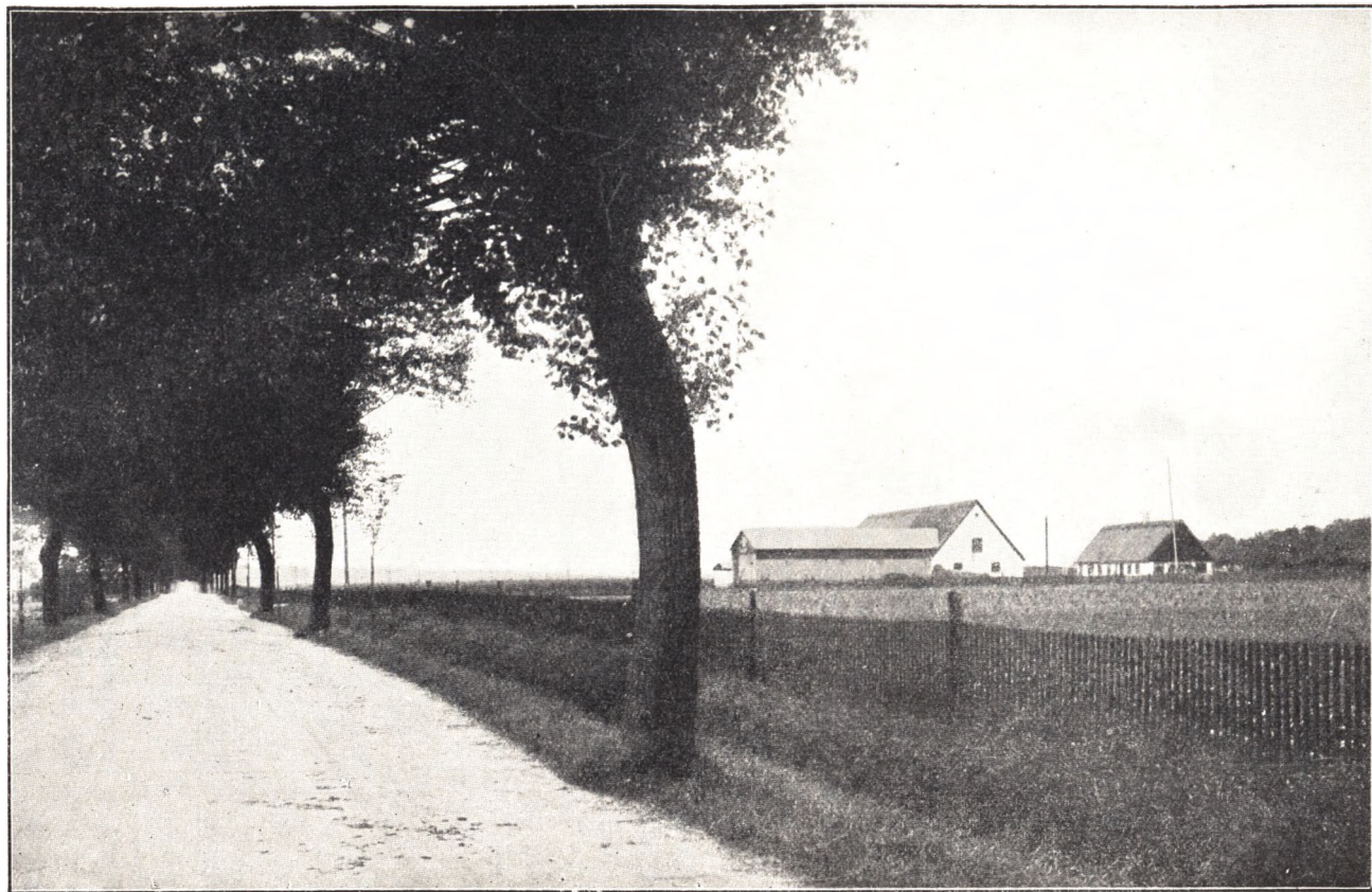
Stuebygningen paa Kærehavegaard.
