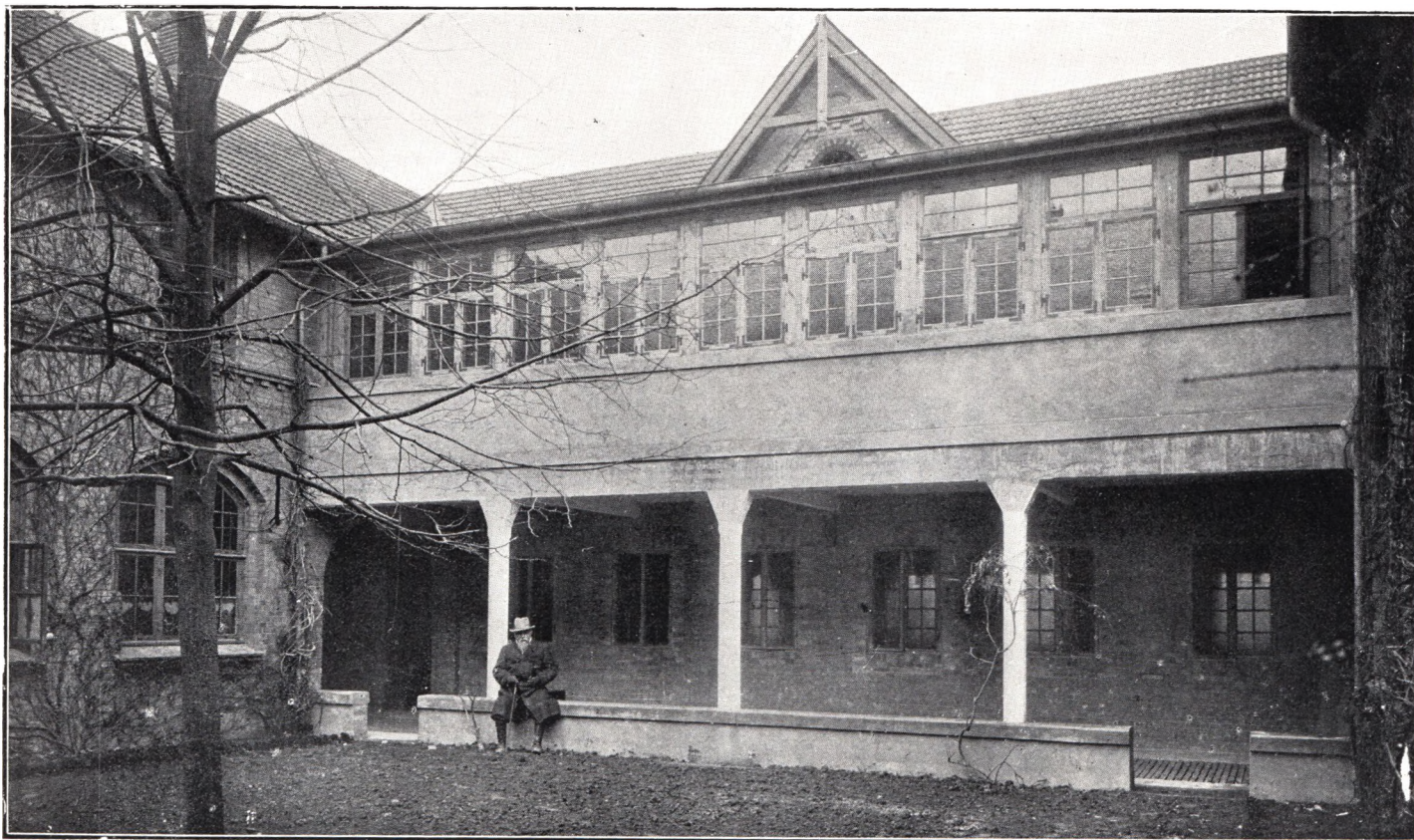
Skolegården i Elevbygningen efter Ombygningen i 1918.
