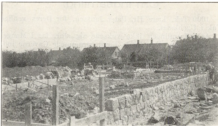
Arbejdspladsen, hvor den nye Kirke rejses.
