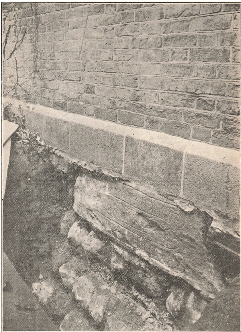
Fundament under Korets Østgavl.
