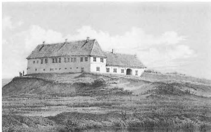
Ryssensten på sin borgbanke set fra vest - år 1868 (efter Richardt, Becker og Secher: Prospekter af danske herregårde). Bøvling Slot, først under Ribe-bispen, fra 1536
