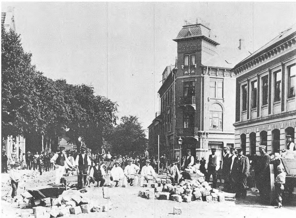
Træerne falder, og Hovedgaden brolægges, 1904. T.h. Hotel Eyde og Midtbanks Ejendom, opført 1901
