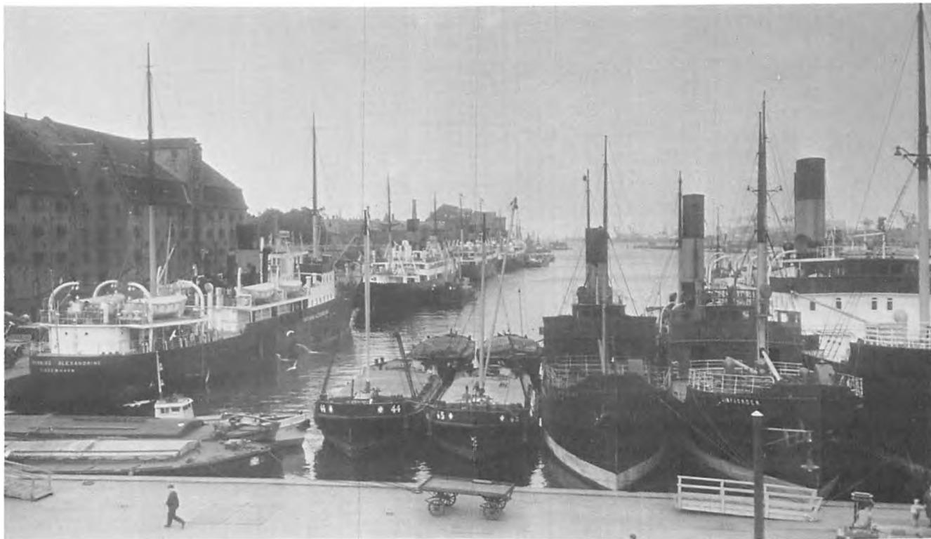
Havnebassinet mellem Larsens Plads og Kvæsthusbroen fyldt op af fartøjer fra DFDS. Til venstre foran pakhuset, som nu skal være hotel, ligger dampskibet Dronning Alexandrine. Fotografiet er taget omkring 1940.
