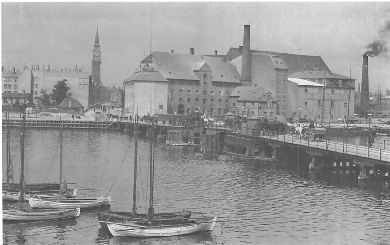
Langebro set fra Amager omkring 1900. Der er endnu byggestilladser omkring rådhusstårnet i baggrunden. Rådhuset blev opført 1894-1905.
