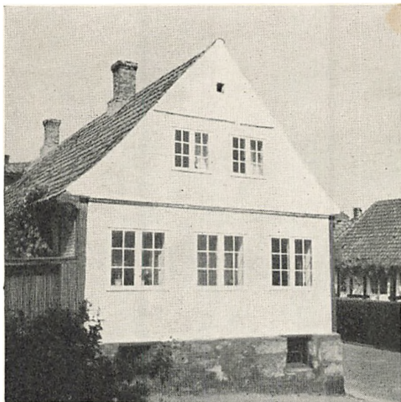
Noget ind i det 19. aarhundrede bliver det almindeligt at grundmure gavlene i bindingsværkshusene. Den her viste salsgavl fra et hus ved havnen i Svanike er med sine vandrette formstels-haand og træudkrugningen ved tagskægget meget karakteristisk for Svanike. (H. H. E. fot.)
