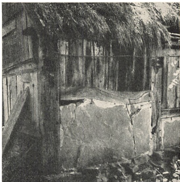
Store heller af sandsten benyttet som udfyldning i bindingsværkets underste favl. Slusehuset ved Ølennens udløb. (H. H. E. fot.)
