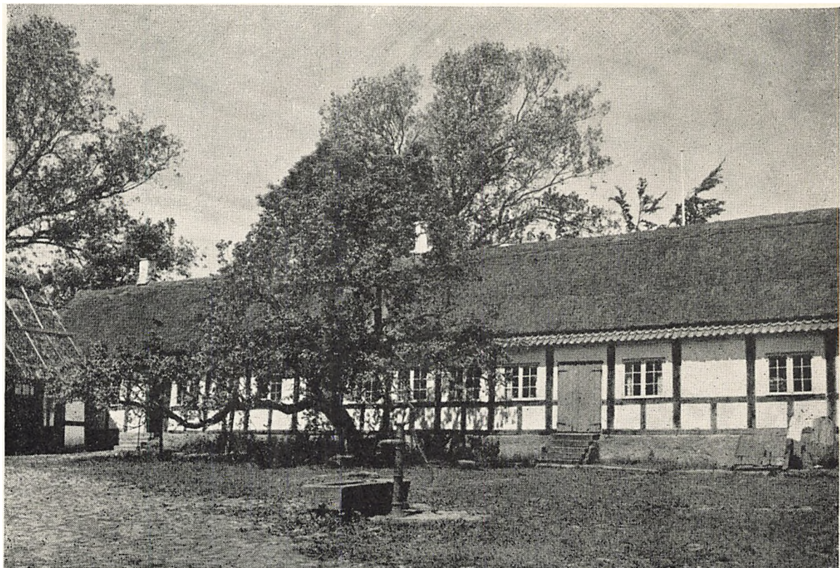
Stuehuset paa Krogegaard ved Gudhjem, bygget 1793. Det store morbærtræ staar i en ganske lille have, der tidligere har været beegnet med et træstakit. Trappe og dobbeltdør fører ind til forstuen ved salen; nedgangen til kælderen under salen ses i billedets højre kant. (H. H. E. fot.)
