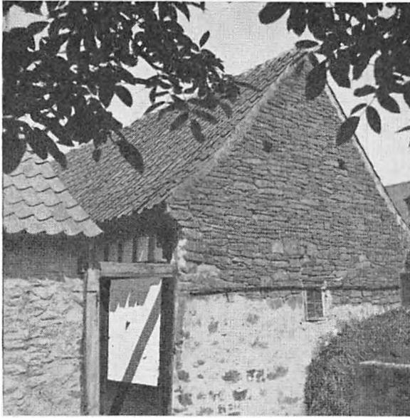
Gavl af smaa flade sandsten: huset til venstre er af sandstensblokke opmuret i ler. »Bonngården« i Nexø, en tidligere avlsbrugergaard, der endnu har alle sine bygninger i behold.
