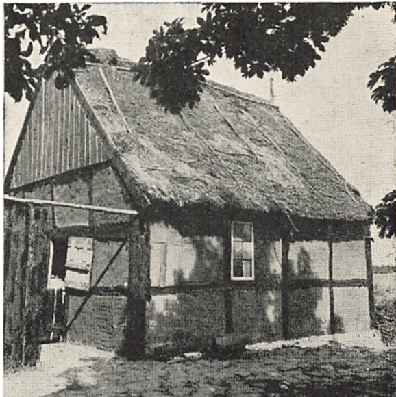
To fags bod paa et sted ved Ringeby bro i Vester Marie sogn. Den træklædte gavl har tidligere enten været lerklinet eller balmvundet om lodrette støjler. (H. H. E. fot.)
