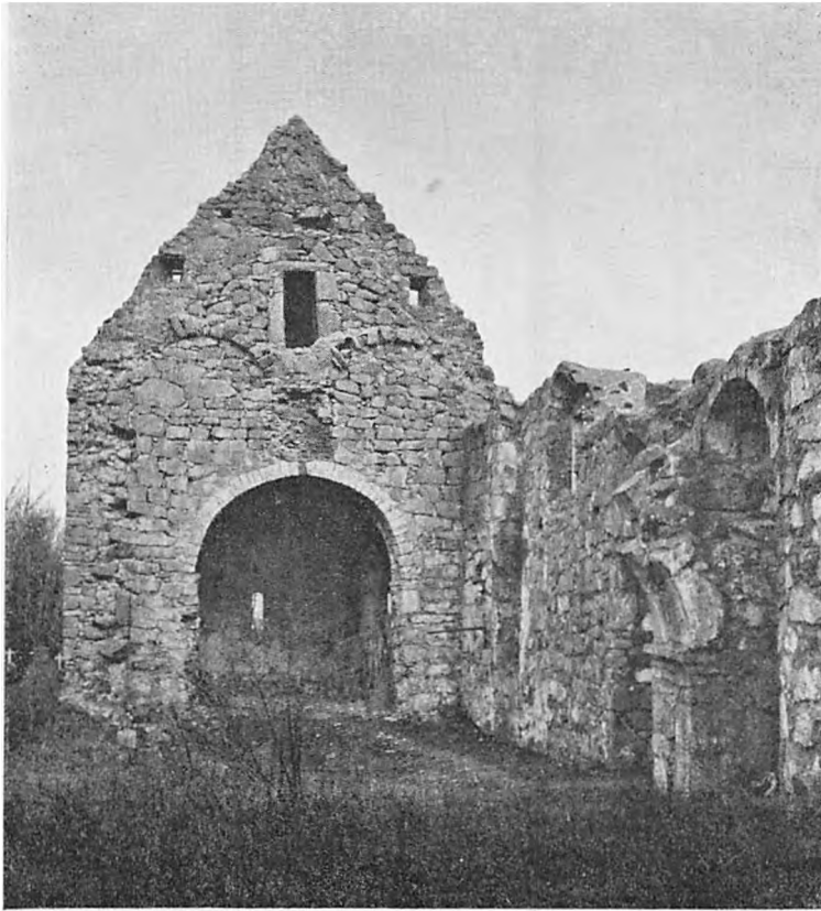
Østermarie Kirkeruin set fra Taarnrummet mod Skibets Østmur, hvor man over Triumfbuen ser Sporene af Skibets to parallelle Tøndehvælvinger.
