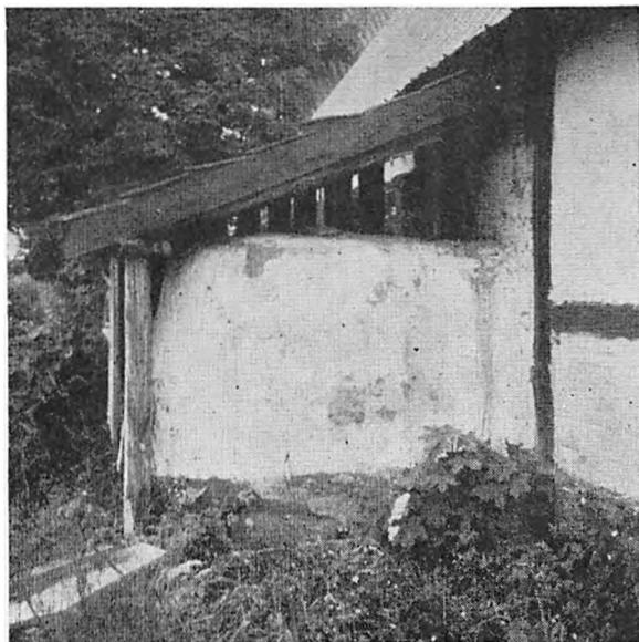
Bagerovn, der stikker ud af husets langside, overdækket med et teglhængt halvtag. Mindre sted i Hølsbavn. (Holger Rasmussen fot.)
