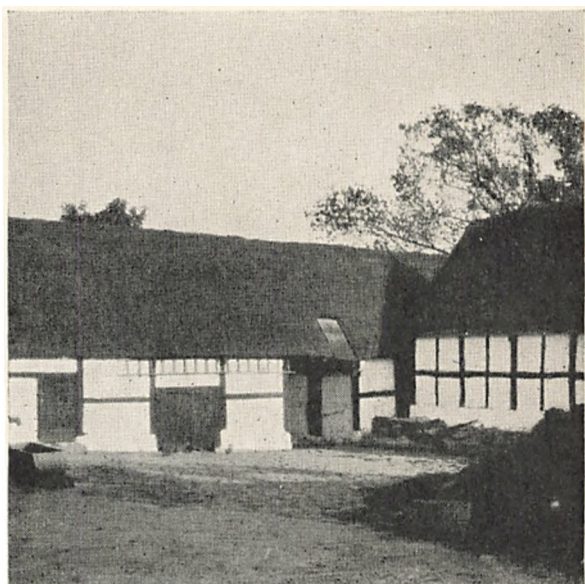
Gaardspladsen set fra nordvest. Østlængen indeholder kørekammer, brændehus, lo og sædgvulv, medens sydlængen udelukkende er lo og lade. Østlængen med de lave døre og brede fag uden lodrette »oplængder« er den ældste. (Dansk Folkemuseum fot.)
