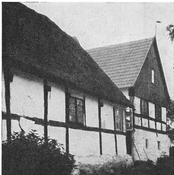
Bahækkegaard i Ibsker sogn. Stuehusets salsgavl og østlængens østside. Terrænet skræner stærkt fra nordvest til sydøst, derfor den vældige forskel i søkkelhøjden. Mærk salsgavlens knægte og lodrem. (Dansk Folkemuseum fot.)
