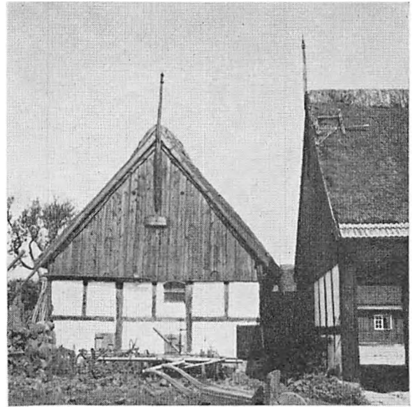
Bræddede gavl med brandstænger af den ældre type paa udlængerne til Riemandsgaard i Østerlars sogn. Det rodkalkede stuehus ses i baggrunden. (H. H. E. fot.)
