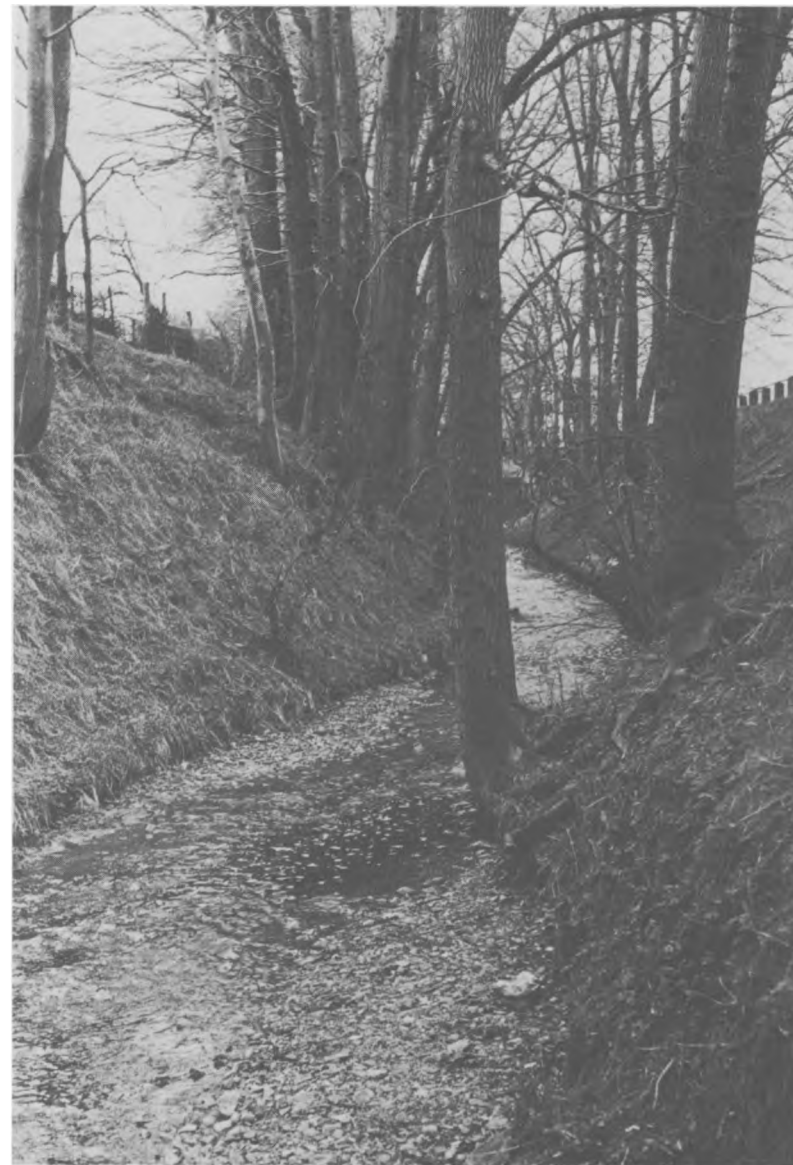
Afløbsrenden fra Emdrup Sø mod Lersø (-parken). Billedet er fra 1969, før renden blev rørlagt. Til højre skimtes Lyngbyvejen/Kongevejen. Fra: Nationalmuseets 3. Afdeling.
