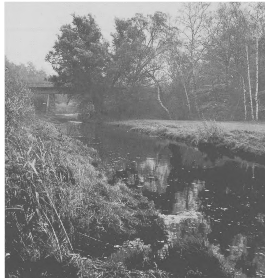
Et af de største anlægsarbejder i forbindelse med anlægget af Lyngby-Vedbækbanen (Nærumbanen) var dæmningen og broen over Mølleåen.
