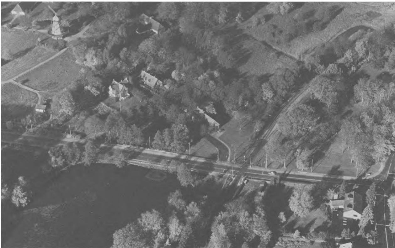
Fuglevad. Øverst i venstre hjørne ses en del af Frilandsmuseet med Fuglevad Vindmølle, der er museets eneste oprindelige bygning. Vandmøllen ligger delvis skjult bag træerne omkring åen. Aerodan Luftfoto.
