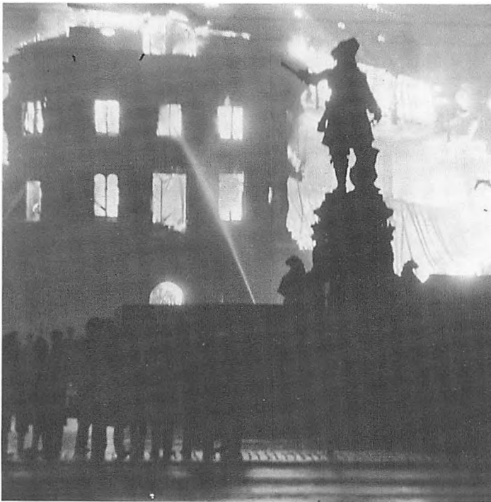
I 1944 blev Ø.K.s hovedsæde offer for så grov schalburgtage, at Tvedes bygning fra 1907 blev totalt ødelagt. Holger Jacobsen genopførte den næsten uændret 1946-49. – Nordfoto.
