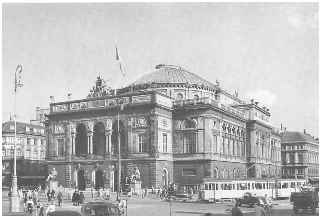
Vilh. Dahlerups og Ove Petersens Kgl. Teater fik lov at stå temmelig urørt i over 100 år. Man søgte nemlig at løse dobbeltdriftproblemerne i 1930'erne ved at overtage Statsradiofoniens »Stårkasse«, og det berørte jo ikke direkte den gamle bygning. Foto ca. 1960. – Bymuseet.
