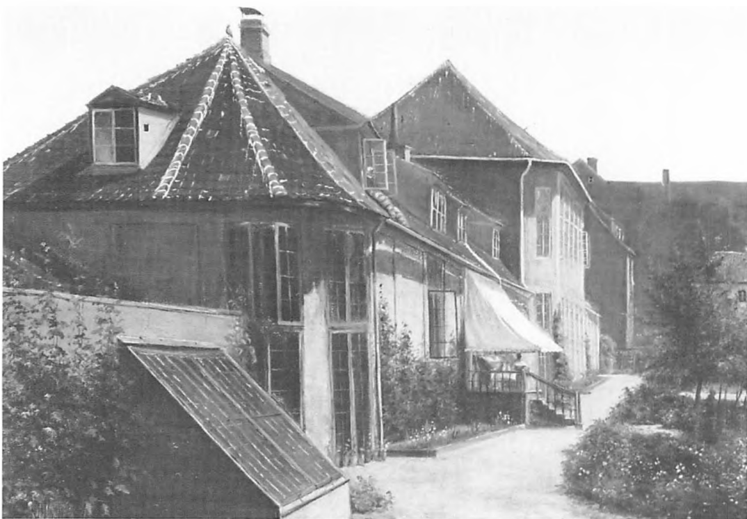
Botanisk Have havde i 1780'erne fået sin egen direktørbolig, plantesamling, bibliotek og gartnerbolig. Havens chef boede her til 1872, da haven flyttedes til Østervold. Ved nedrivning af bygningen blev der skaffet plads til Charlottenborgs udstillingsbygning, som opførtes på dette område. Maleri af Vilh. Kyhn. – Bymuseet.
