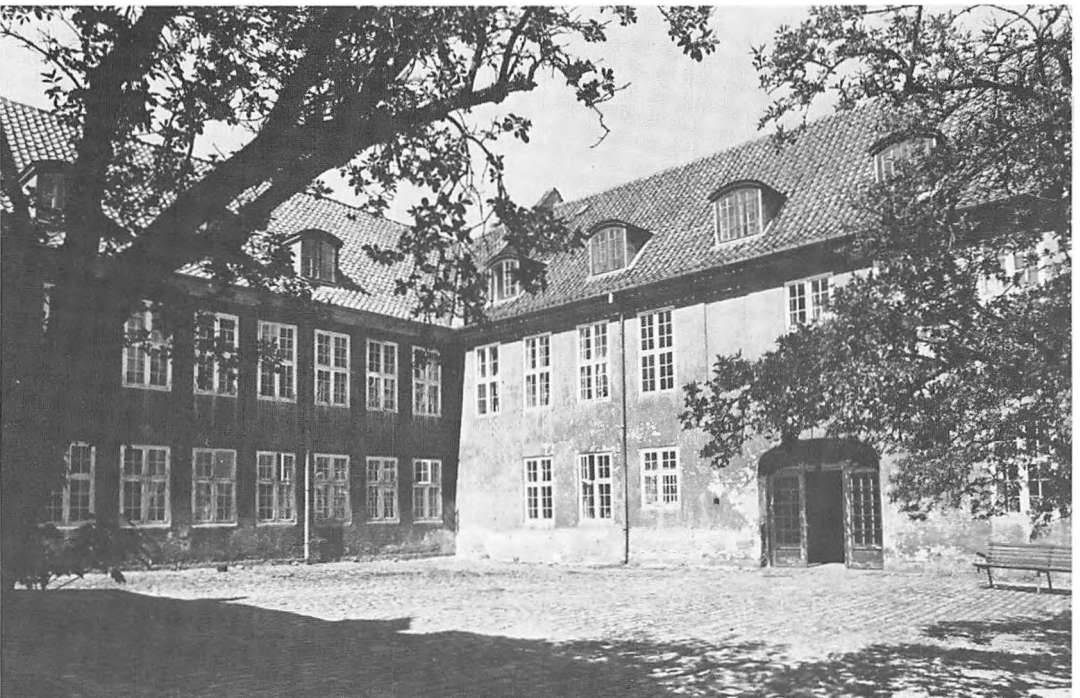
Også her er der blevet skabt ganske maleriske, moderne statskontorer med træer i gården i de gamle kaserne-omgivelser. – Foto Hans Jørgen Ørslev 1985.
