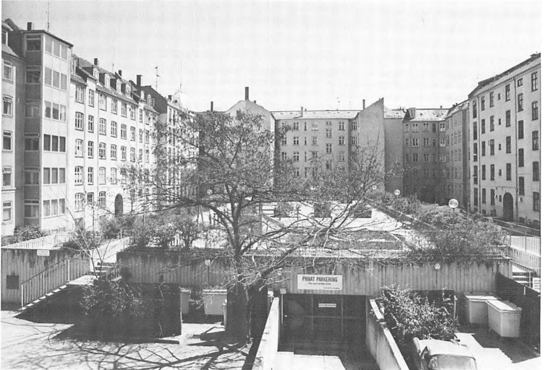
Selvfølgelig har det givet luft og lys i karreen at få baghusene væk, og der er også blevet plads til garager under gårdanlægget i midten. Men det er og bliver en nødløsning. – Foto 1985 Hans Jørgen Ørslev.
