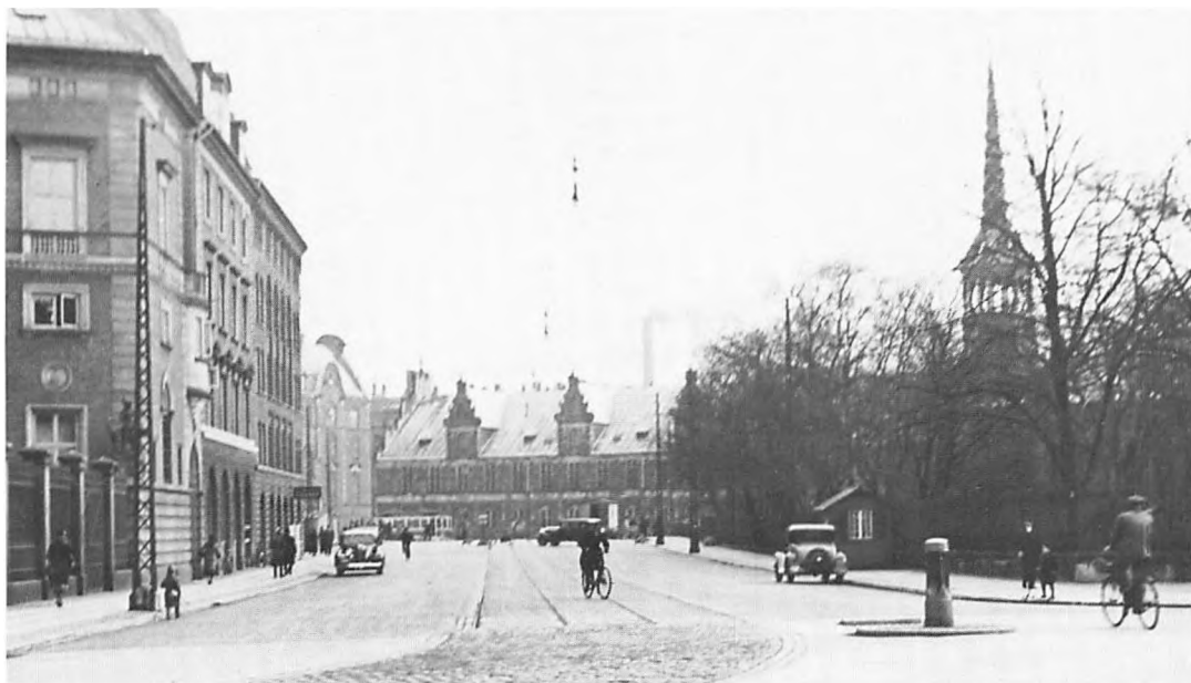
Sådan tog samme parti sig ud ca. 80 år senere. Dette sidste stykke af den nye gade blev en del af den nyanlagte Havnegade med Børsbro-forbindelsen til Knippelsbro. Det er Martin Borchs tilbygning til Nationalbanken, restaureret 1913-17, som ses til venstre. Fot. 1948. – Hassing.
