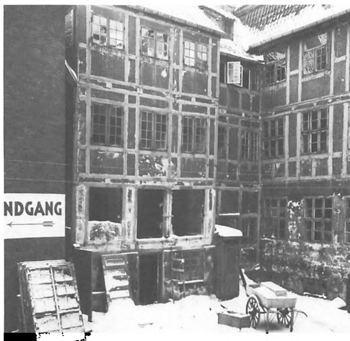
Gården bag Brødremenighedens hus i nr. 21 viser en typisk 1700-tals byggestil: pudset facade til gaden, men bindingsværk til gårdsiden. Her er nedrivningen i 1931 lige begyndt. Fot. Sophus Bengtson. – Nationalmuseet.
