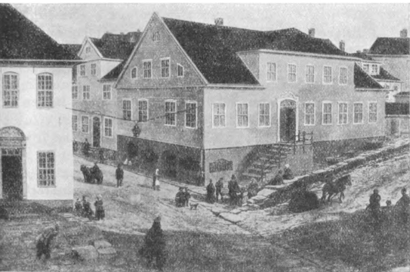
C. J. Hambros hus på nedre hjørne av Strandgaten og Muralmenningen. (Efter maleri av I. C. Dahl, 1840.)
