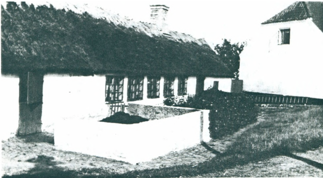
Huset i Strædet. (Foto 1926)
