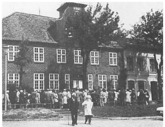
Historisk Samfund foran Skipperhuset ved havnen i Tønning.
