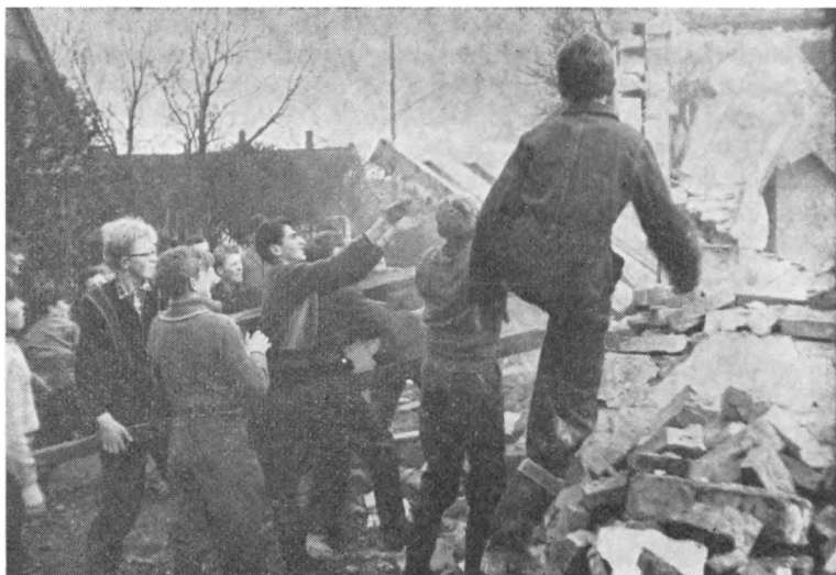
Moderniseringsprocessen er begyndt. Gartnerhuset jævnes på bekostning af østfløjen
