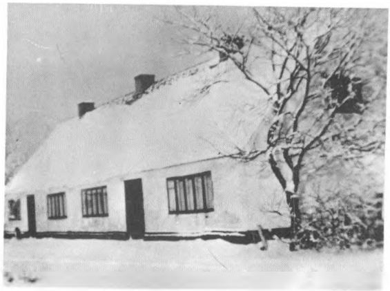
VII. H. Det gamle stuehus på St. Døes før 1960
