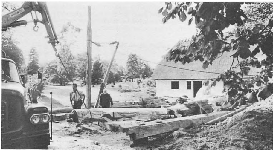
Fig. 12: neg. 1725. 11: 17-07-64: Møllebygger Dahlerup (under kranen) da montagen af skæreværket paabegyndtes.
