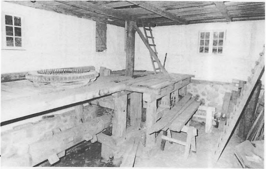
Fig. 18: neg. 1736.06: 17-10-64: Skæreværket færdigt; montagen af gearet begyndt. Erection of stone hurst completed; gear installation is in progress.
