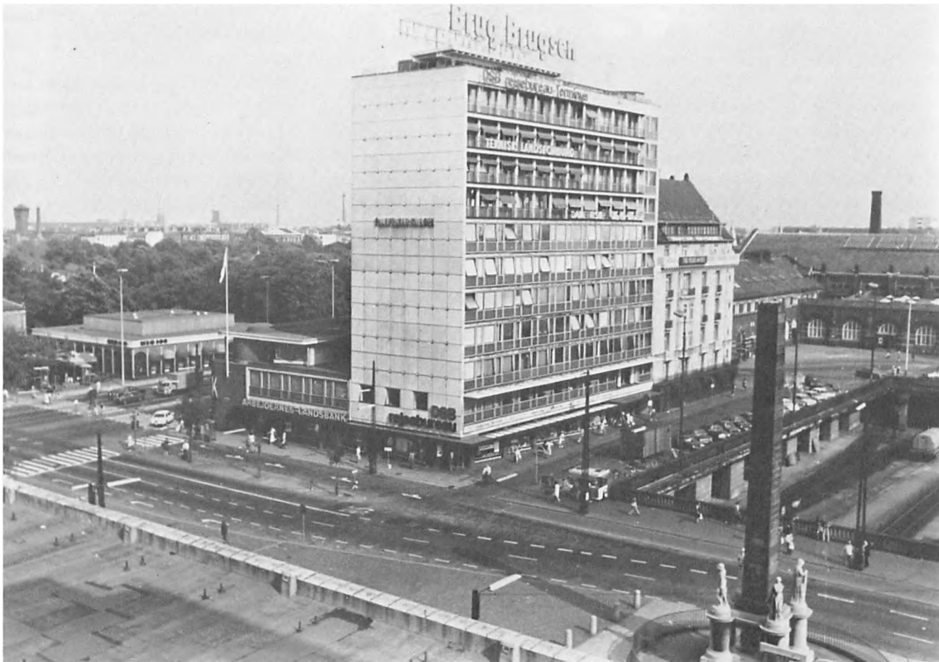
Panoptikon, nutidsbillede. Kun den lave bankfløj på hjørnet af Bernstorffsgade er bevaret fra den gamle Panoptikonbygning.
