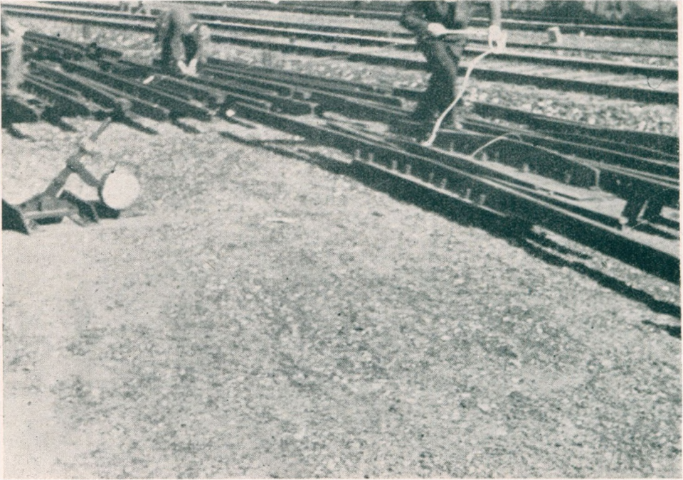
Forbindelse etableres med et fjernere Sprængningsled.
