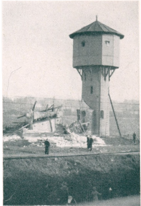
Fra Esbjergs store Jernbanesabotage: Vandtaarnet paa Baneterrænet har faaet en ordentlig en paa Sinkadusen.
