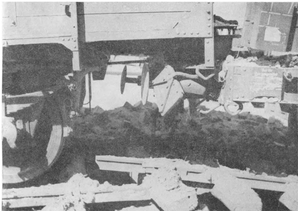
Nærbillede af mindre Skinnesprængning. Der krævedes ikke meget Sprængstof hertil. Det var Antallet af Bomber og Sprængninger, som gjorde Udslaget.
