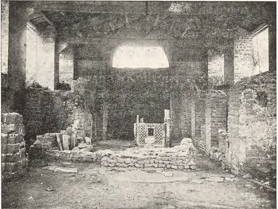
Ruiner fra Basilikaen St. Alexander. (Kollegiet ejer paa Via Numentana, 9 Mil fra Rom, nogle smaa Katakomber, hvortil ogsaa Basilikaen hører; f. T. er den under Restauration.)
