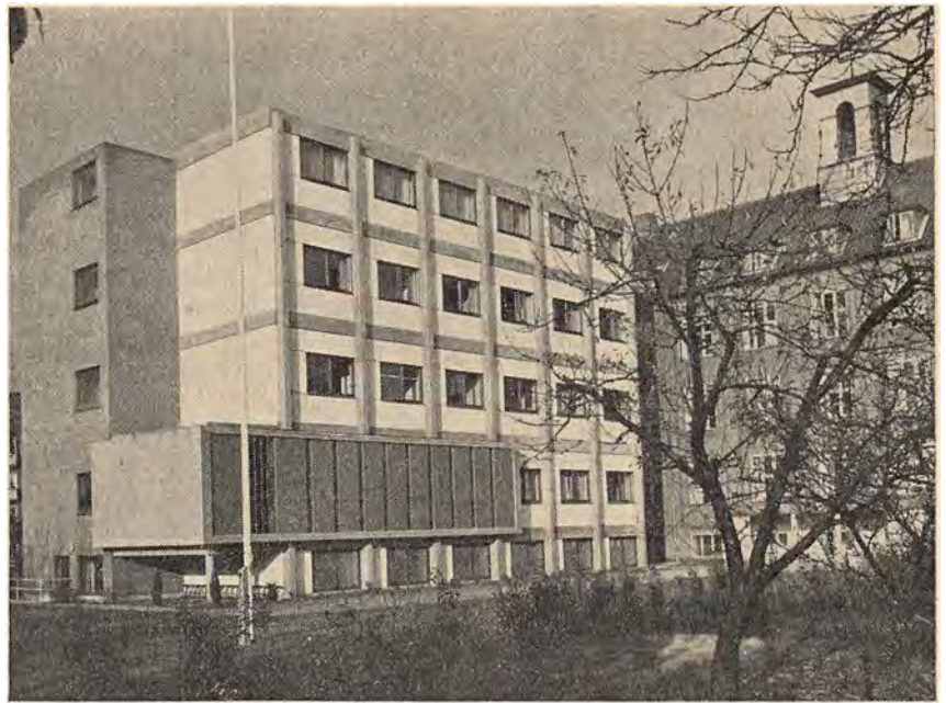
Den nye fløj sammenbygget med den gamle tilhøjre. Den lave, fremspringende bygning er søstrenes kapel.
