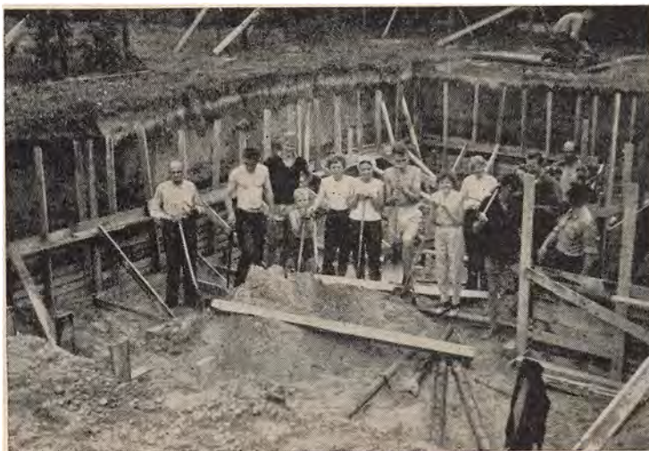
Et af de tidligere arbejdshold, fotografet, mens der blev arbejdet på fundamentets afstivning.
