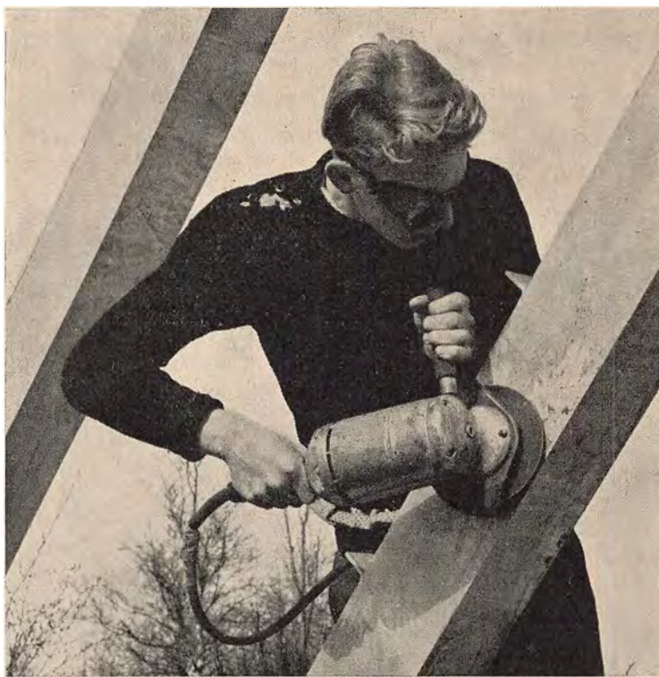
Der er blevet udrettet meget af de unge katolikker, som vil rejse en valfartskirke i Øm. Her er en af dem ved at tage tagkonstruktionen under behandling. Se også billede og tekst side 9.
