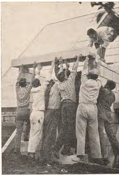
Når man løfter i flok er det muligt at nå mange ting, også at få lagt den store tværsten på plads, som de flittige unge arbejdere her er ved at lægge over indgangen til den nye kirke i Øm.
