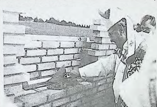
Ud over grundstenen murede biskoppen et stålør indlagt tegninger over kirken samt et dokument, der beskriver, hvorfor man bygger en ny katolsk kirke på stedet.
