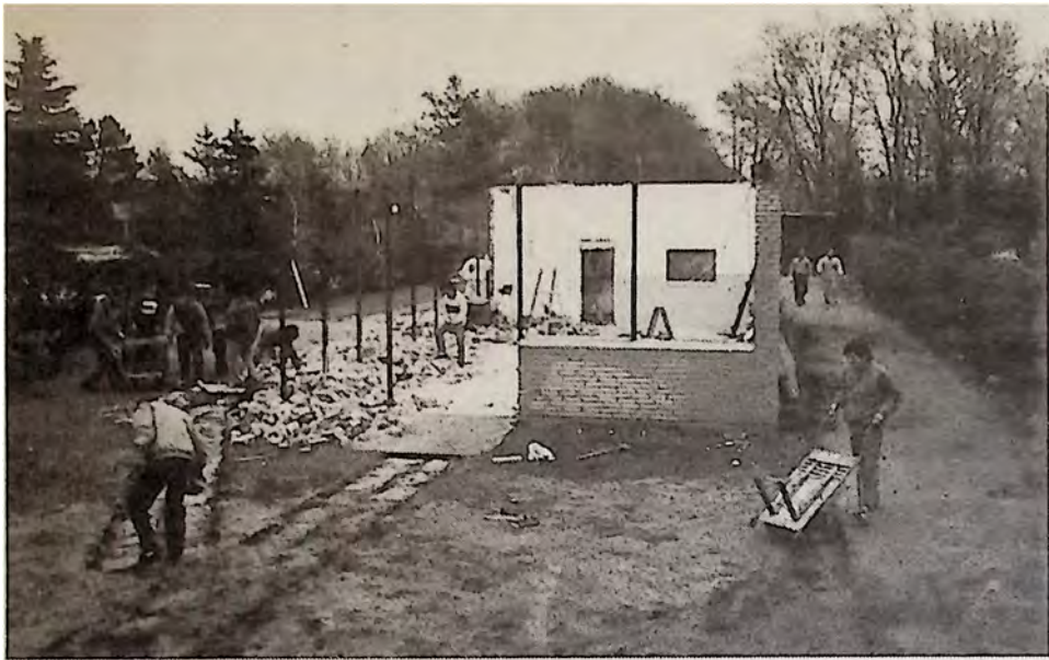
Det er inspirerende at arbejde sammen med vietnameserne på kirkecenteret i Hjørring. De møder trofast op på byggepladsen, når håndværkerne har brug for dem
