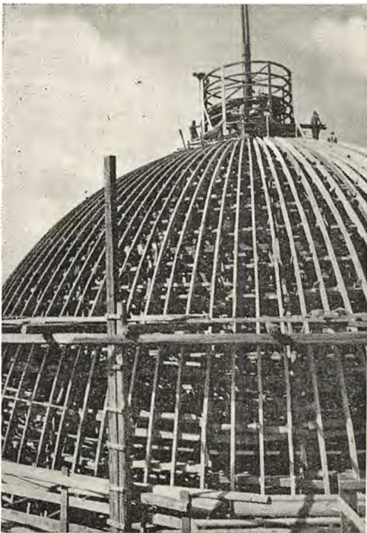
▲ Der arbejdes paa Kuppelbygningen ➤ Lidt efter lidt tager Bygningen Form
