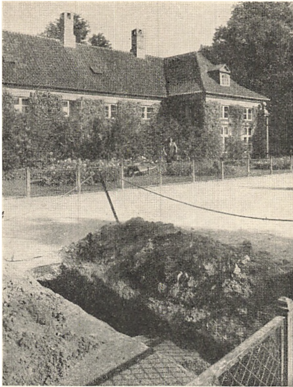
UDGRAVNINGEN VED INDGANGEN til Frederiksberg have set fra syd. Bemærk den smalle tværføj, der angiver de oprindelige bygningers hele dybde. Helt til venstre skimtes lidt af den forårsblomstrende Magnolia stellata .
