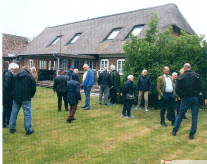
Enggård i Hjemsted, som siden 1993 har været hjemmet for Wilma og Marcel van den Hengel. Stuehuset set fra haven.
