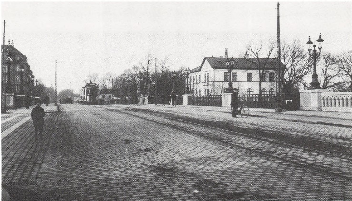
Svanemølleviadukten omkring 1925. Men nu er vejen blevet brolagt og de elektrificerede sporvogne er kommet til. Der er dog stadig (forrest i billedet) alle gråspurves livret: Varme hestepærer! Midt i billedet er linie 1 på vej mod hovedstaden; til højre for sporvognen traktørstedet Svanholm. Møllen er forsvundet, den nedbrændte i 1892, tilbage står de sidste rester af dampmøllen.
