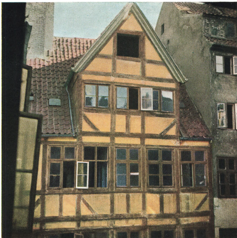
Forhusets gårdside fotograferet kort før nedrivningen påbegyndtes. Adelgade 75 ses i højre side.
