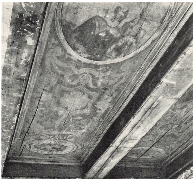
Loftet i firefags-stuen i forhusets stueetage, som det tog sig ud efter fjernelsen af en senere loftbeklædning. Den barokke dekoration anes gennem den ensfarvede rokokko overmaling.
