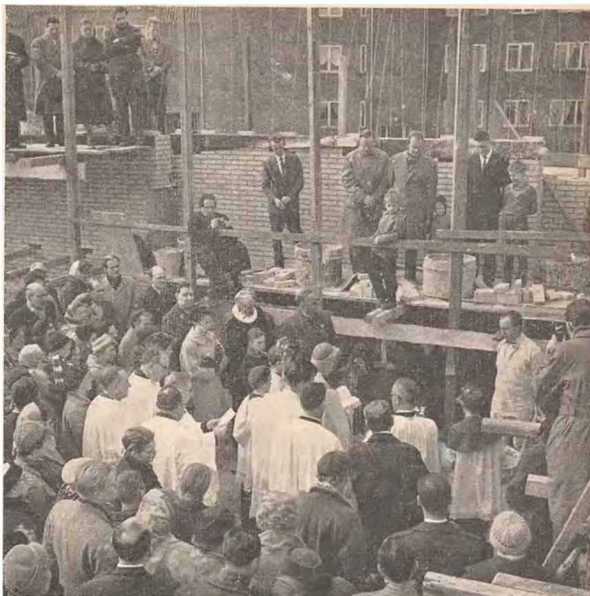
I Peters første brev skriver apostelen: »Lad jer selv som levende stene opbygge til et åndeligt hus.« (Fra grundstensnedlæggelsen til Sct. Nikolaj Kirke i Hvidovre.)
