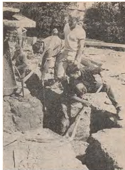
Støbning af grund.
