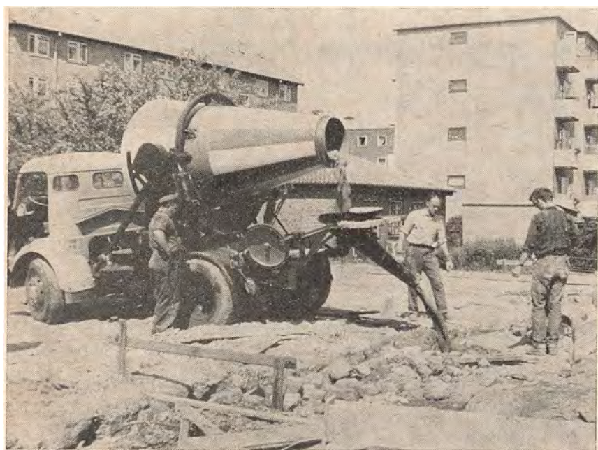
Levering af betonen.
