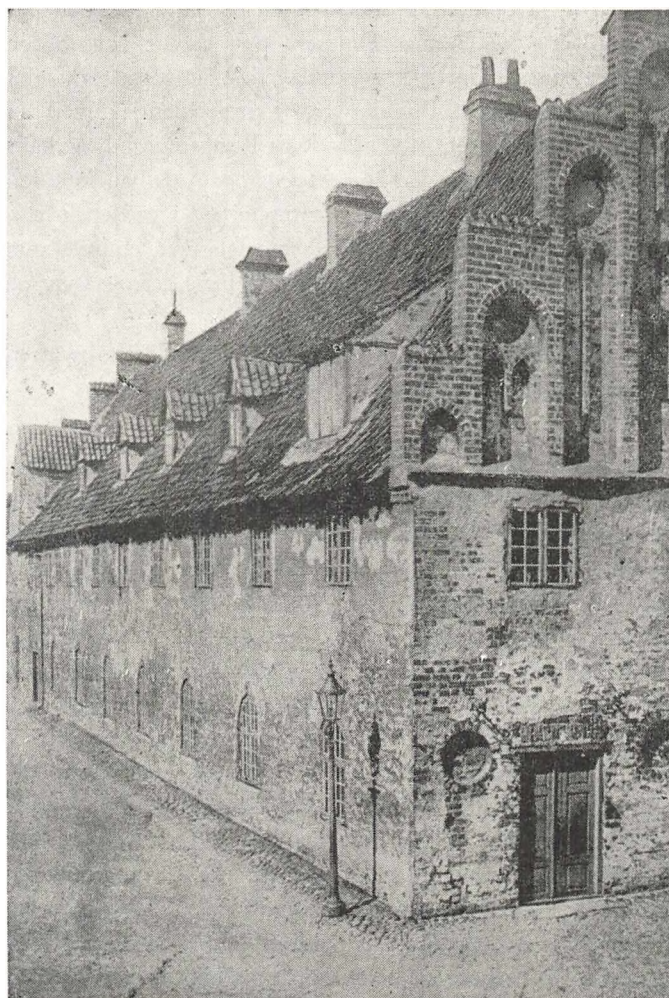
Klosteret i Helsingør før restaureringen, - set udefra.
