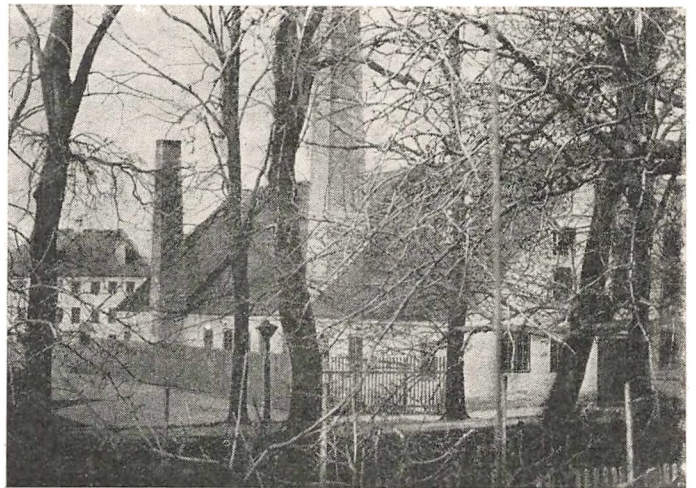
Det gamle Kobbevalseværk med Hovedbygningen i Baggrunden.
