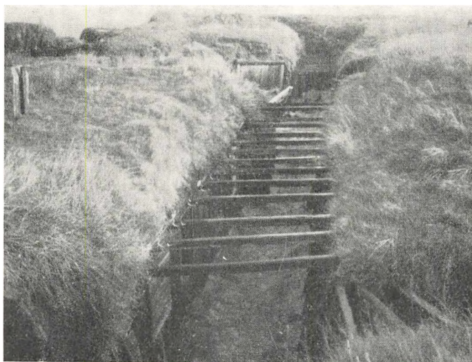
Spodsbjerg Batteri. Man ser den træbeklædte og træafstivede forbindelsesgang mellem de 2 kanonstillinger nedgravet i klitten med beboelseskasematter indbygget i gangens venstre side.
