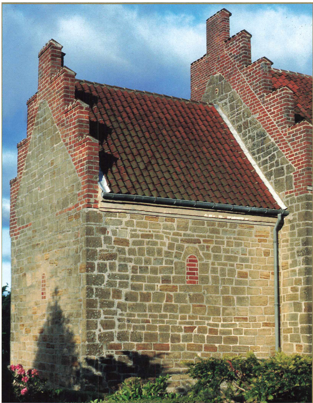
Figur 2: Valby Kirkes kor set fra nordøst en tidlig sommer morgen. Bemærk, foruden de to originale vinduer, at der øverst i skibets gavl er et fint lille rundvindue, som har givet lys ind i loftsrummet. Lige under nordvinduet findes der et 5 cm højt såkaldt stenhuggermærke, ↑ , der kan have haft at gøre med aflønningen af stenhuggerne.
