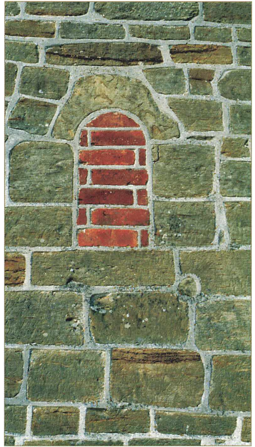
Fig. 3 (herover): Valby Kirke, opmåling med snit af korets østvindue (tv) samt udsnit af murværket med korets ligeledes tilmurede nordvindue (th). Bemærk den tydelige forskel i stenenes farve samt deres mørke revner. Overalt ses mærker efter stenhuggernes pikhamre og mejsler (efter Danmarks Kirker og foto: EN)
