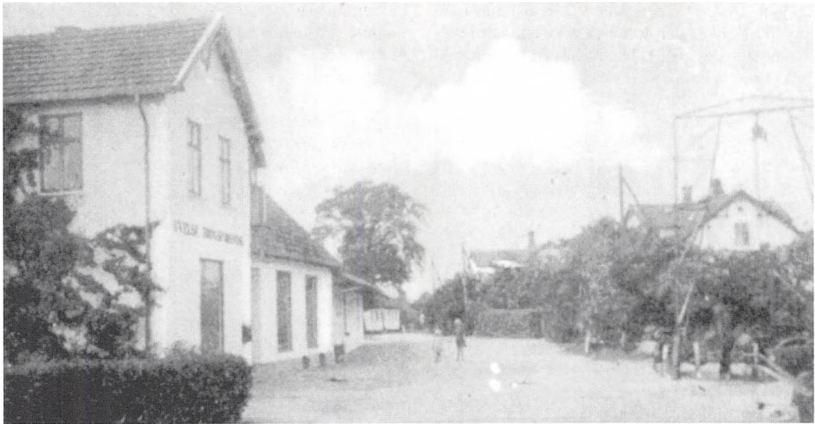
Uvelse brugsforening, sognets vigtigste dagligvareforretning, blev startet i 1906.
