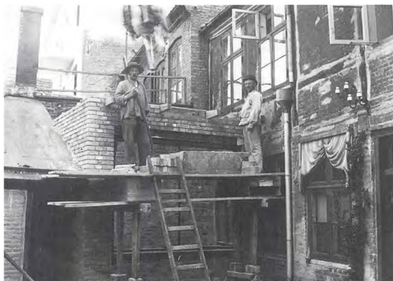
To murere under opførelsen af en tilbygning bag urmager og guldsmed Peter Henningsens nyerhvervede ejendom Storegade 13 ca. 1911. I tilbygningen indrettedes værksted. For murerne var arbejdstiden lang om sommeren, men den kortere arbejdstid om vinteren gjorde til gengæld lønnen så meget mindre i den koldeste tid. Inde i forretningen var arbejdstiden derimod uændret lang året rundt. Foto i HAM.
