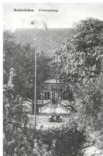
Jomfrustien 12, ca. 1910. Bygningen var oprindeligt et pakhuis i tre etager, opført i 1832 som baghus til Slotsgade 21. Efter byens overtagelse af hele Slotsgade 21 komplekset havde en eskadron soldater fra slesvig-holstenske dragonregiment kaserne i bygningen. I 1882 erhvervedes bygningen af den nystiftede frimurerloge »Josva til de tre broere«, der siden har haft til huse her. Indtil 1978 var bygningen adskilt fra Jomfrustien ved en stor have. Postkort i HBA.
