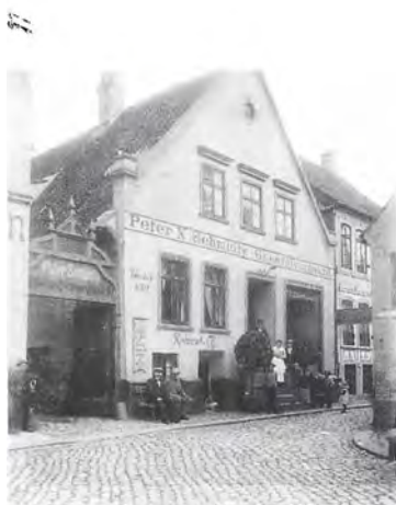
Elektrisk gadebelysning var ikke noget almindeligt syn kort efter århundredskiftet. Her ses dog en enkelt gadelampe på Peter N. Schmidts gæstgivergård, Højgade 1. Huset er nu nedrevet, og på grunden ligger missionshuset Ansgar. Foto i HBA.
