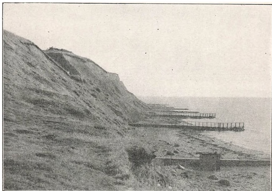
Høfdeanlæg ved Gilbjerg hoved. (R. H. Stamm. fot.)
