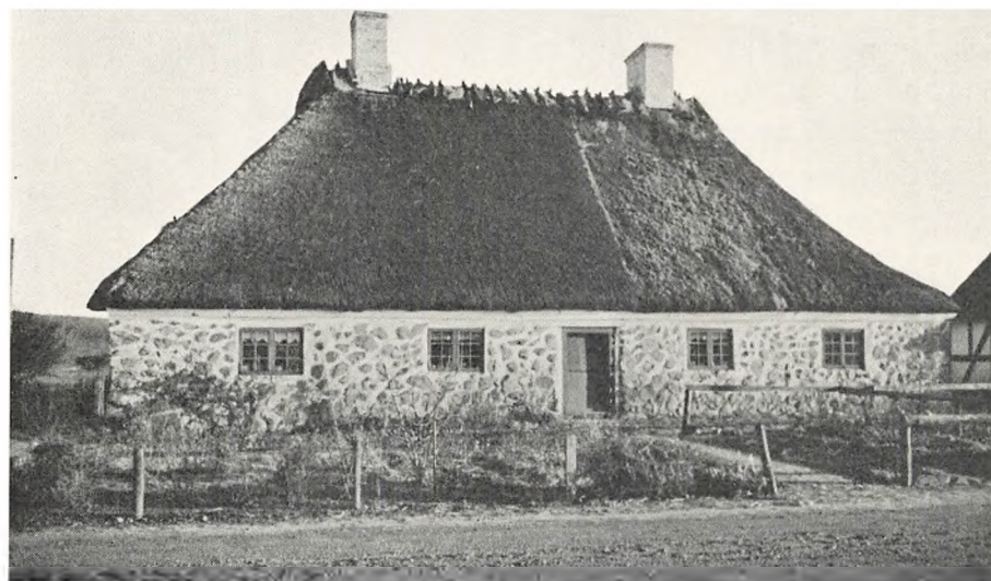
Hospitalbygning i Diernisse
