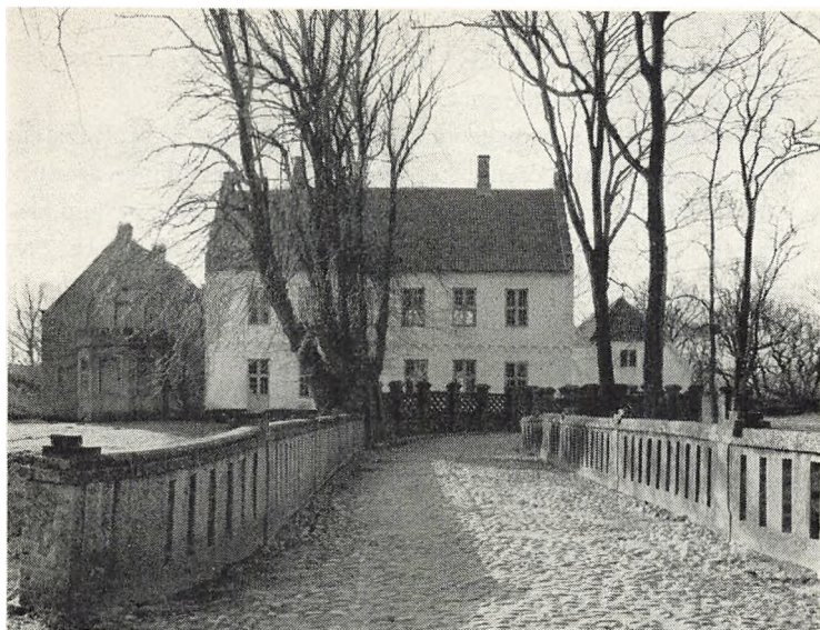
Indkørselen til hovedbygningen (fot. Niels Elswing).
