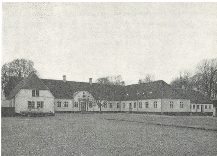
Hovedbygningen set fra øst (fot. Niels Elswing).
