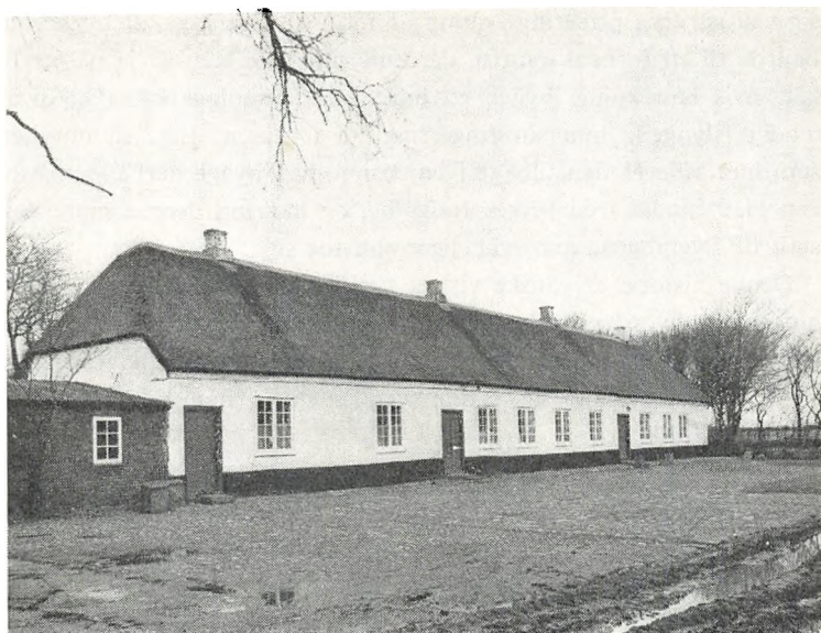
Hovedbygningen set fra øst (fot. Niels Elswing).
